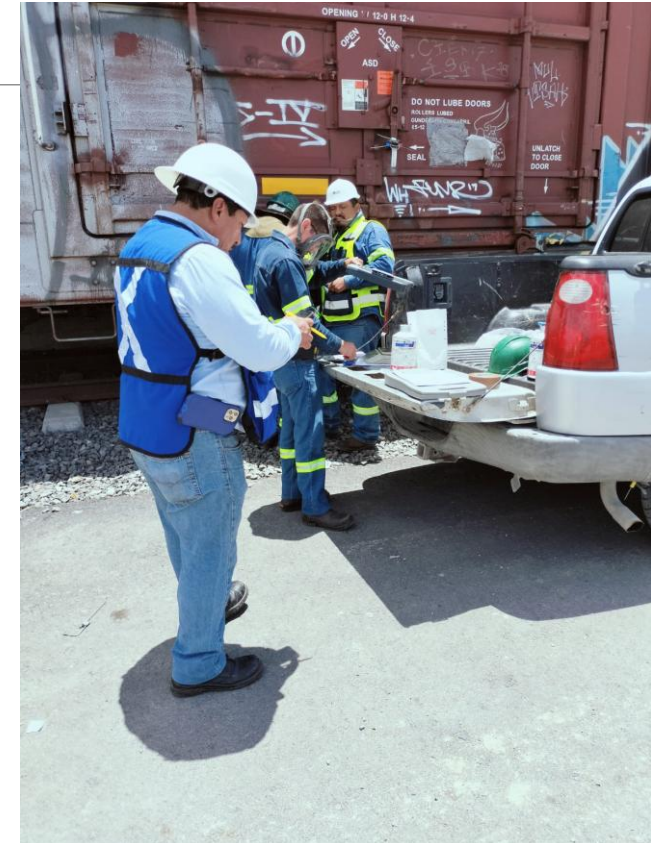
Operario técnico dosificando
