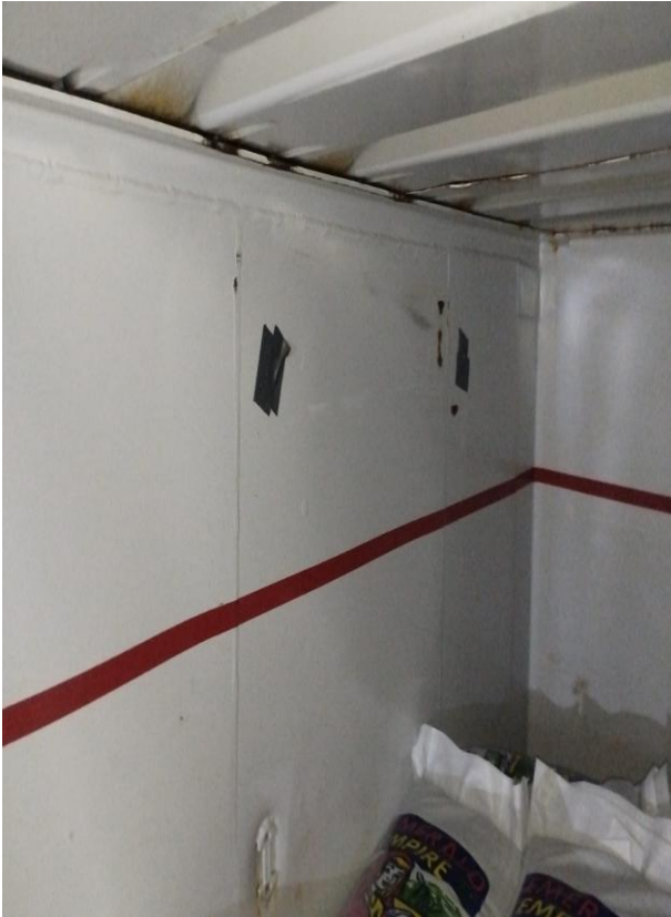
Sellado de posibles fugas
