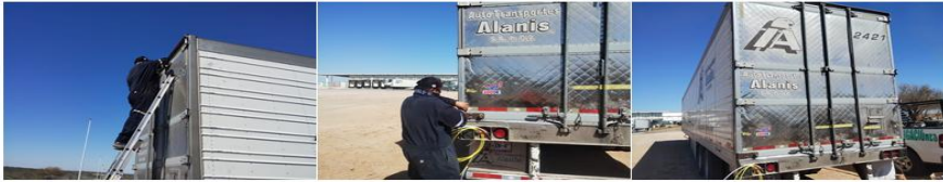
10.- SE REALIZAN LAS CONEXIONES DE MANGUERAS AL DOSIFICADOR Y EVAPORADOR, SE ENCIENDE EL MECHON DEL CILINDRO DE GAS LP PARA QUE EMPIECE A CALENTAR EL AGUA DEL EVAPORADOR.
