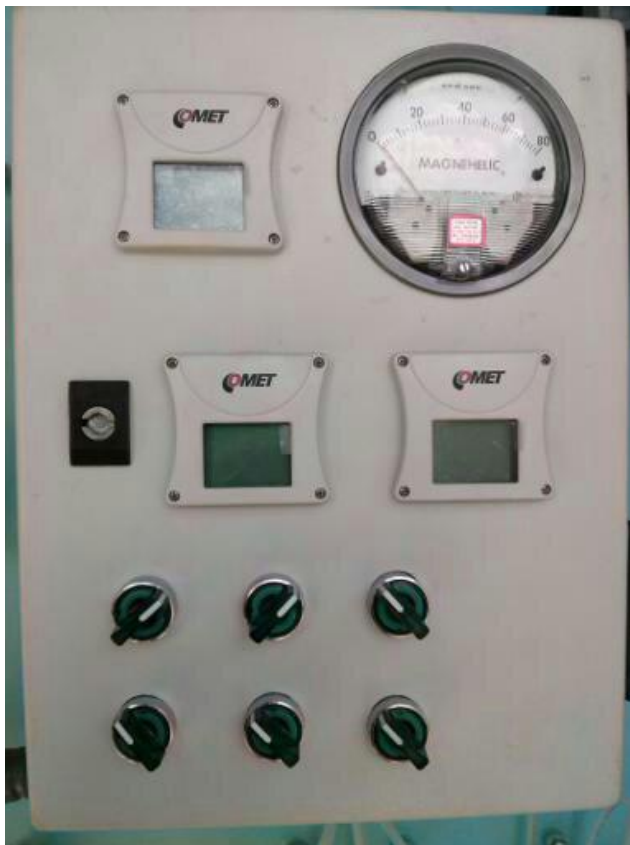
Manómetro de presión diferencial 0 – 80mm
